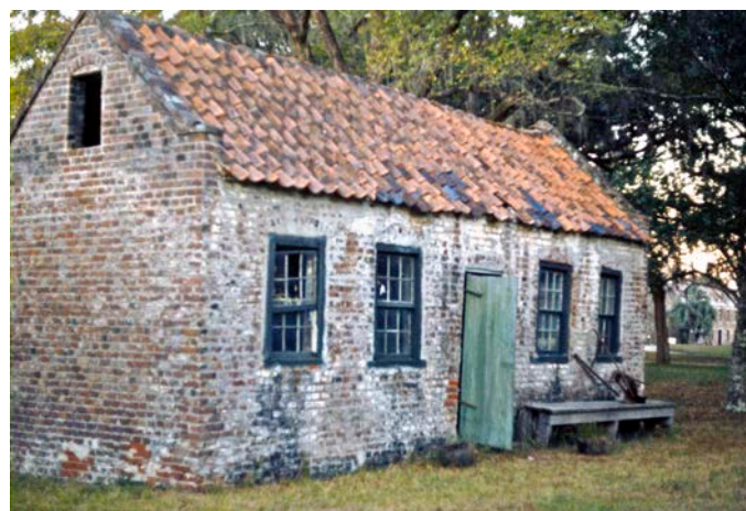
1974 - cabine escrava original sobre plantação, SC
