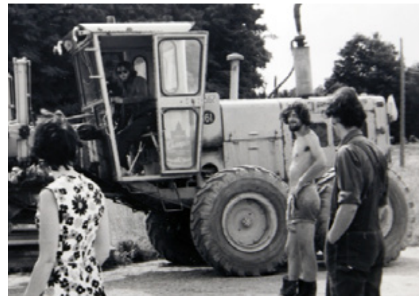
Dr. Godfrey foretrak at leje maskiner. Her er Adam ved at anlægge grusvejen ned til den nye farm sammen med Mark og mig i korte bukser.
